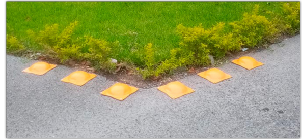
Instalación de boyas
